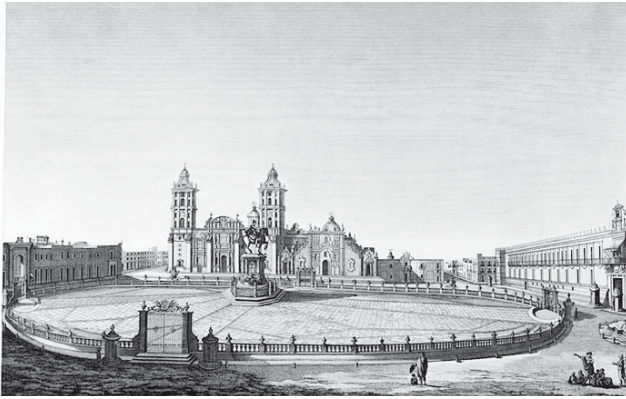
Abb. 20. "Ansicht des großen Platzes von México" Tafel III der Vues des Cordillères. Foto: Agustín Estrada, Mexiko-Stadt.
